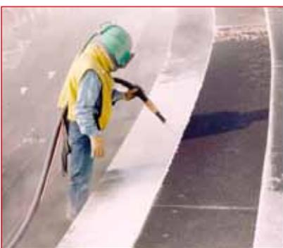
Dopo preparazione delle superfici e sigillatura dei giunti, il formulato è in grado di aderire e formare una membrana unica, resistente e compatta, finita per un maggiore effetto estetico con verniciatura poliuretanica POLISTAR P867.
